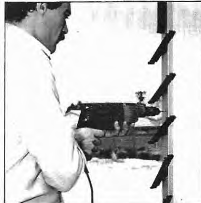
22. Fixar um elemento lateral numa das ombreiras do vão e, na ombreira oposta, o outro elemento lateral, conforme se descreve nos números 1 e 2.
