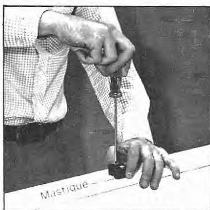
23. Aparafusar os blocos LF 580 à pádieira e ao peitoril (os blocos serão fixados no peitoril sobre uma camada de mastique fina). (Ver desenho B).
