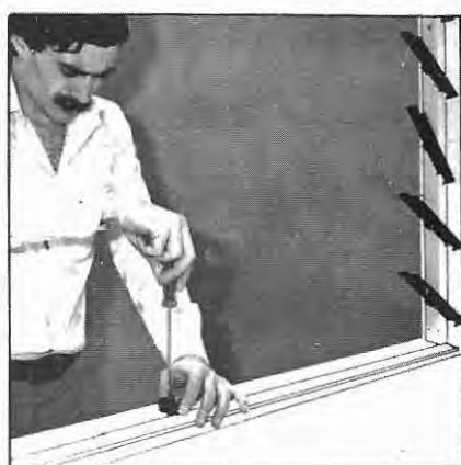
23. Aparafusar os blocos LF 580 à pádieira e ao peitoril (os blocos serão fixados no peitoril sobre uma camada de mastique fina). (Ver desenho B).
