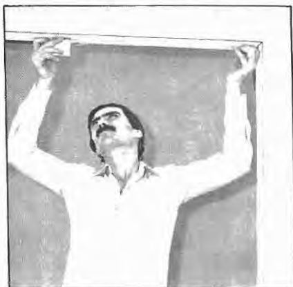
21. Medir a largura do vão e marcar na pádieira e no peitoril a linha central do bloco LF 580, de acordo com o número de prumos necessários.
