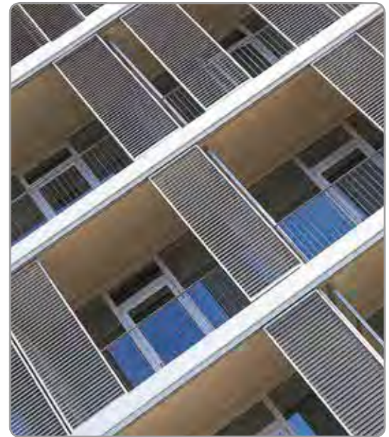
Loggia®, Centre de services intégrés de soins pour seniors, residential, Luxemburg (LU)
